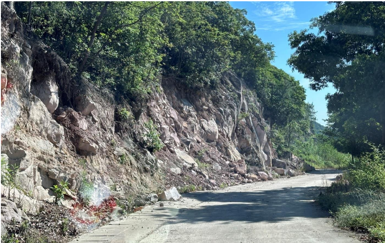
图 4-7 现状边坡节理裂隙发育（BP4）
