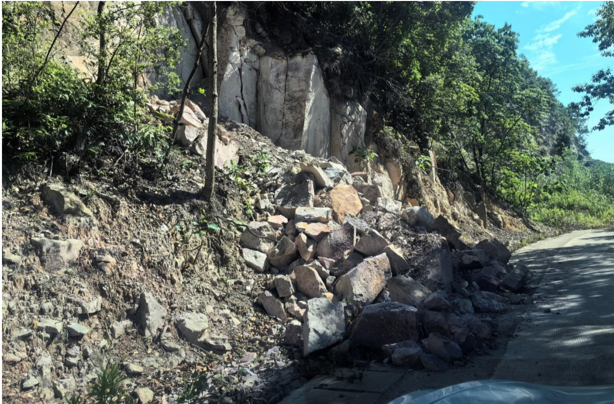
图 4-6 现状边坡崩塌堆积体（BP4）
