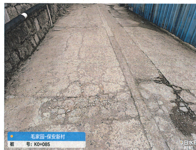
板块破损、管道施工修补不良
