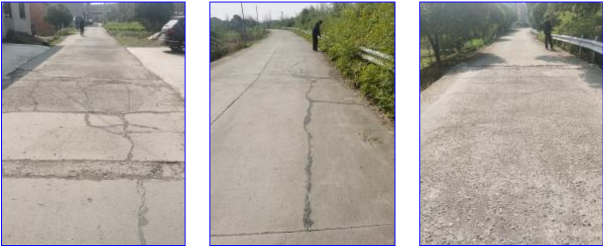
板块破碎 裂缝 沉陷
