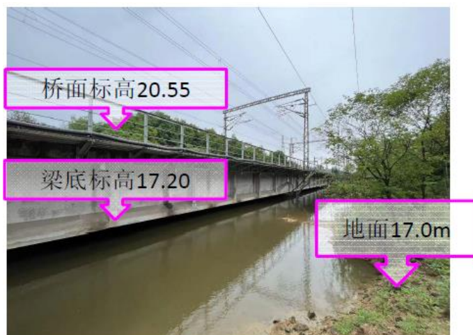
浙赣铁路梁底标高示意图
