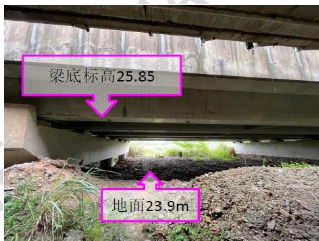
高速公路桥梁梁底标高示意图
