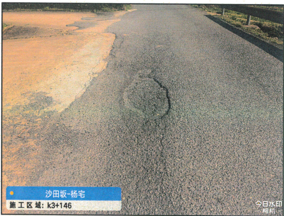
网裂、坑洞、修补不良
