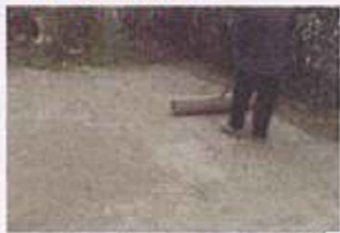
铺沙垫层2cm，滚压同时 用直尺扫平
